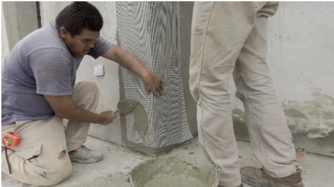
*Encuentro muro/columna en esquina - Aplicación de basecoat sobre revoque termoaislante.*
