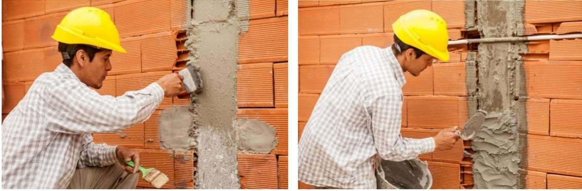
*Encuentro muro/columna - Aplicación de promotor de adherencia y revoque termoaislante sobre estructura de H°A°.*
