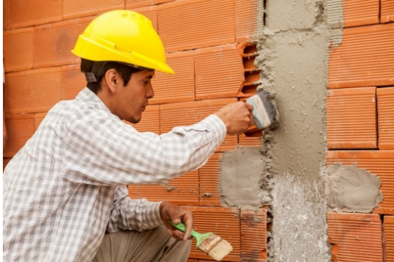
Aplicación de promotor de adherencia y revoque termoaislante sobre estructura de H°A°.
