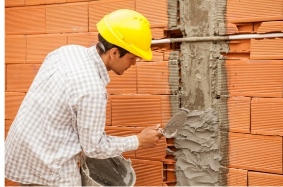
Aplicación de promotor de adherencia y revoque termoaislante sobre estructura de H°A°.
