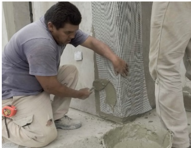
Aplicación de basecoat sobre revoque termoaislante.
