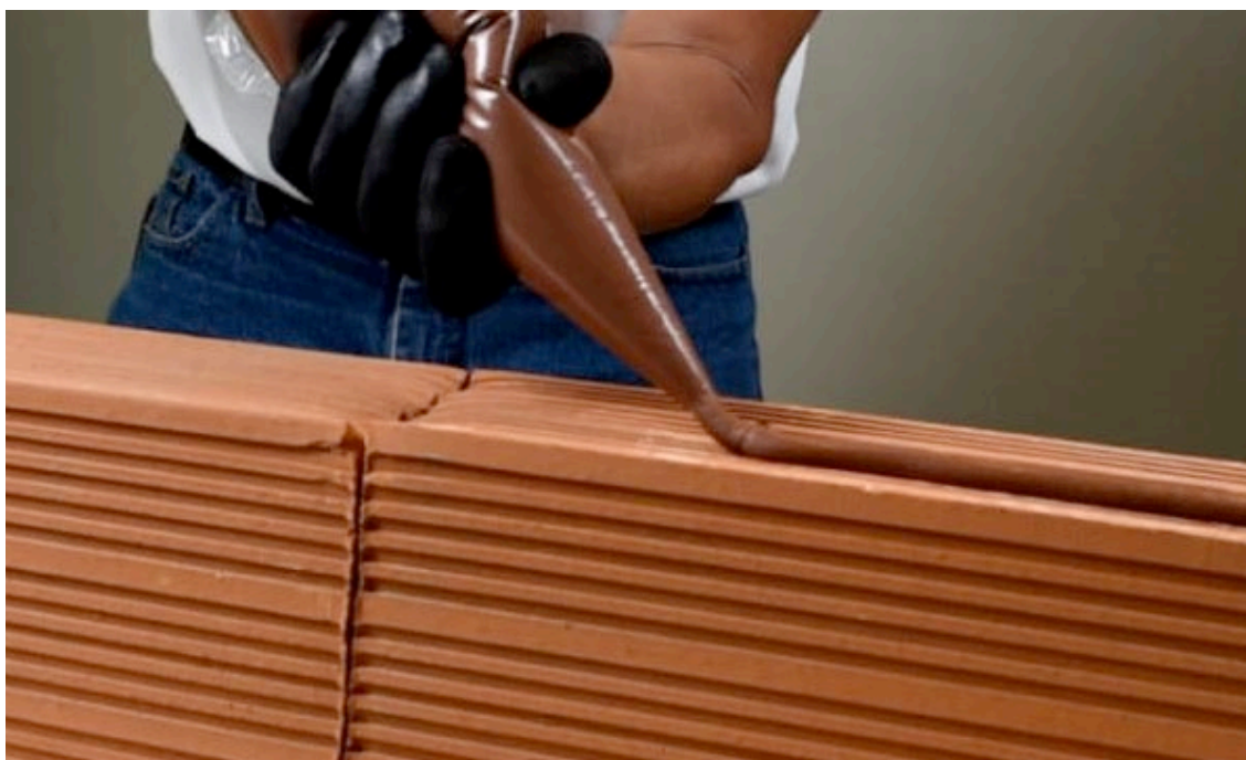
Aplicación de mortero en manga.
